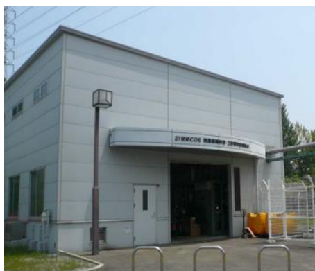
C6棟 COEベンチプラント棟
