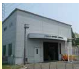
バイオマスエネルギー生産拠点
